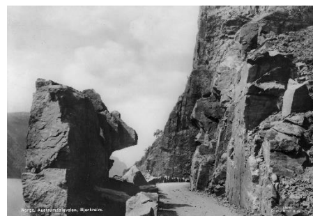
Austrumdalvegen 1940. Den karakteristiske steinen ble fjernet i 1969 da vegen ble utbedret i forbindelse med bygging av vegen til Ørdsdalen. Foto: Mittet & co.
